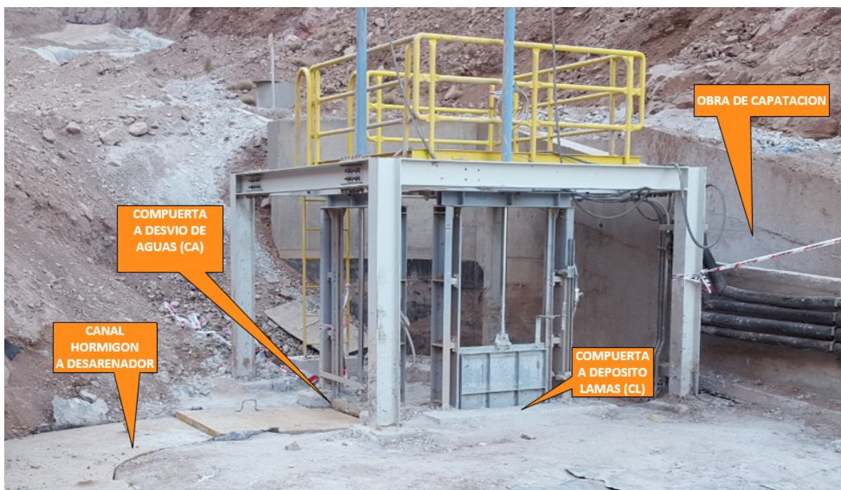
Figura 3-5: Detalle compuertas cajón intermedio IP-A2.
