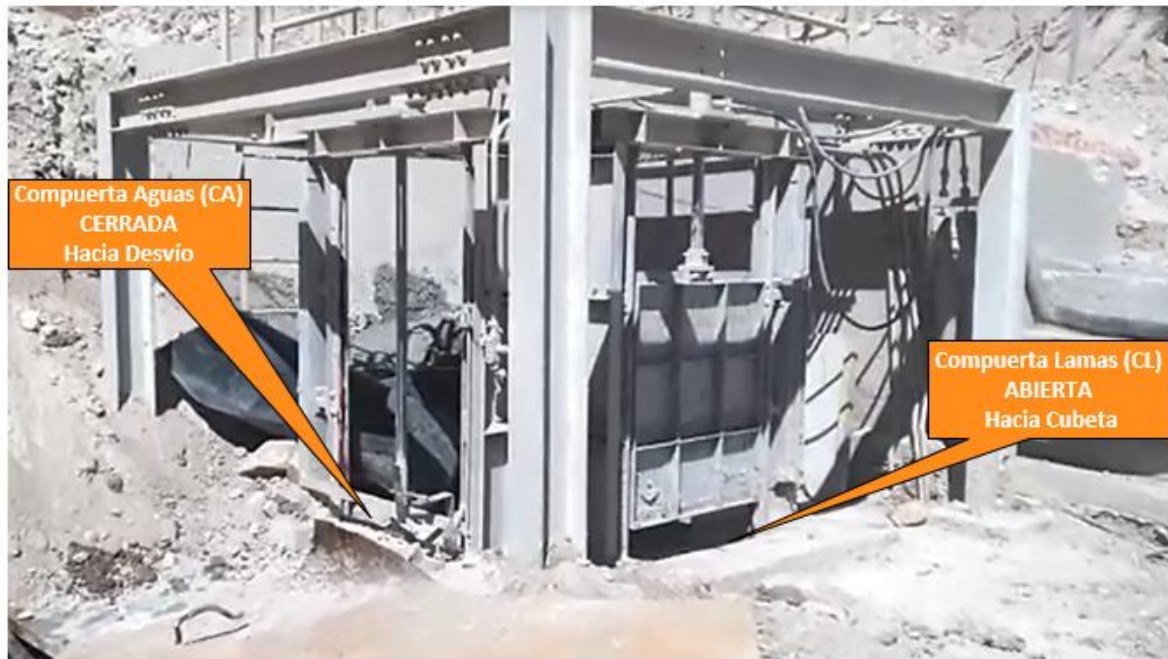
Figura 5-3: Posición de Compuertas para evitar ingreso de Lamas al Desvío de Aguas Naturales.
