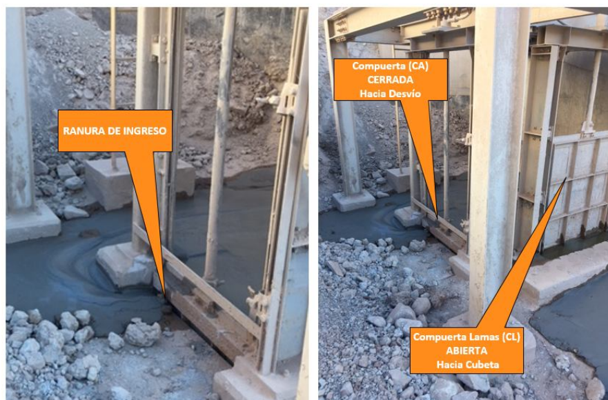
Figura 4-2: Ingreso de lamas al sistema de desvío de aguas naturales y estado de las compuertas al momento del incidente (Ref. 1).
